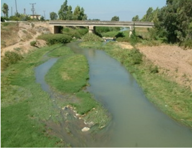
Afrin Nehri Köprüsü
